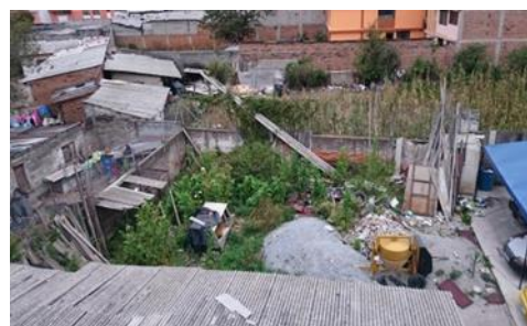
Fotografía No. 4: Vista al Sur viviendas
