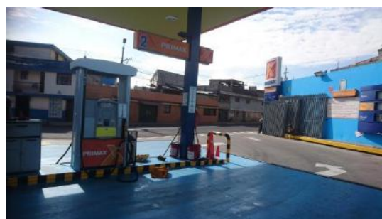
Fotografía No. 23 y 24: Dispensador electrónico y vallas de protección
