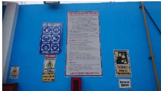
Fotografía No. 19: Procedimiento de trasiego o descarga de combustible
