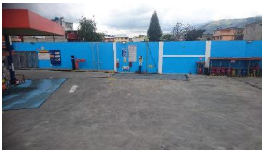
Fotografía No. 20: Área delimitada por color amarillo en las tapas del tanque de diesel. Coordenadas UTM: 772971.01 E – 9969750.08 N
