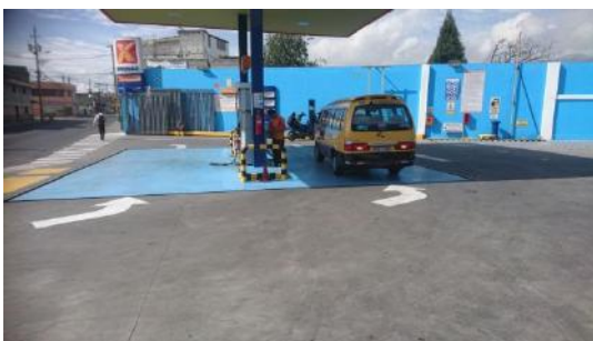
Fotografía No. 25 y 26: Bandeja antiderrame y abastecimiento de combustible a clientes
