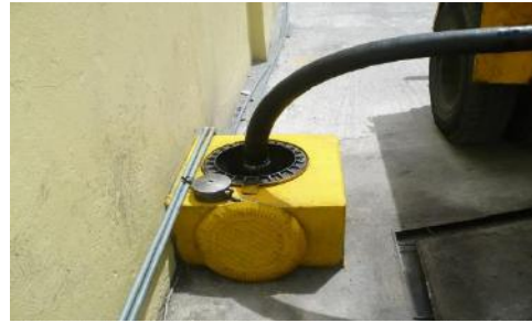
Fotografía No. 17 y 18: Sitio de descarga de combustible y bocatoma con dique
